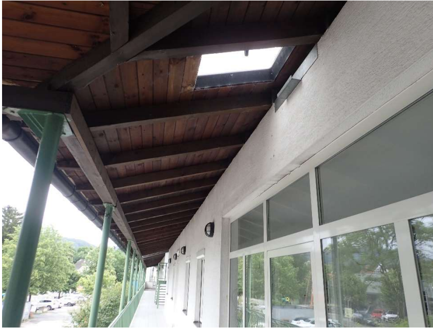
Gebäudeteil 13, Nordfassade (Dachausstieg Laubengang Obergeschoss 1 vor Stiegenhaus 13)
