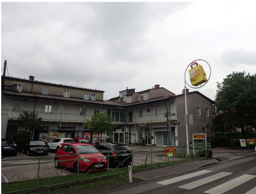
Straßenansicht Gebäudeteil 13 mit Querriegel (Nordfassade, Stiegenhaus 13, Außenanlage Nord)
