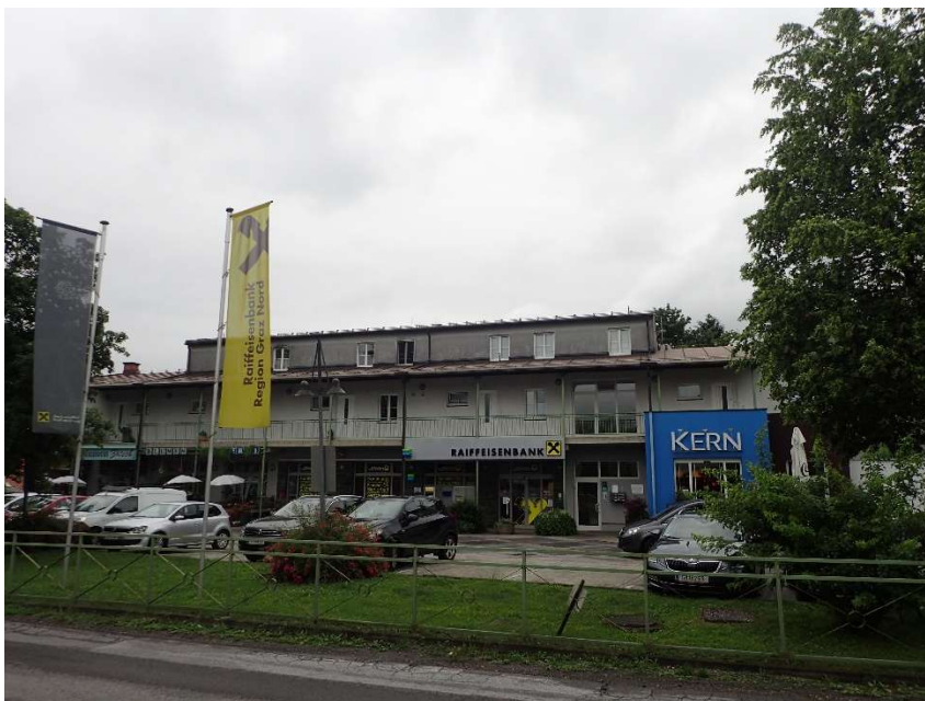
Straßenansicht Gebäudeteil 11 (Fassade Nord)
