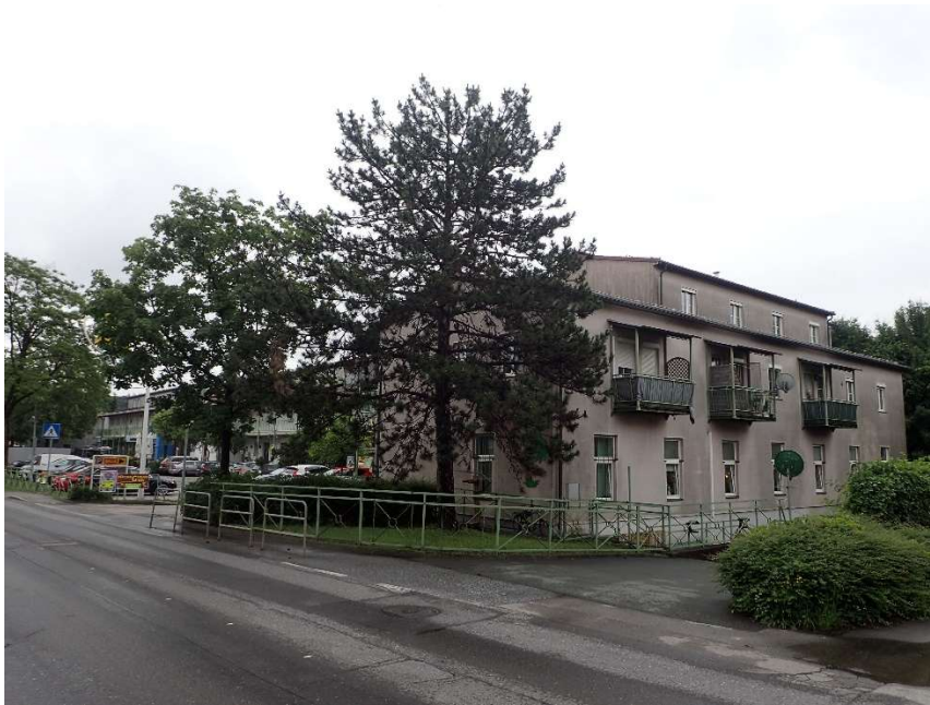
Straßenansicht mit Gebäudeteil 13/Querriegel (Nord- und Westfassade)
