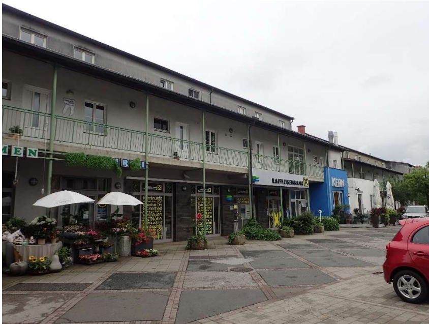
Gebäudeteile 11+13 (Nordfassade, Laubengänge, Stiegenhaus 11)
