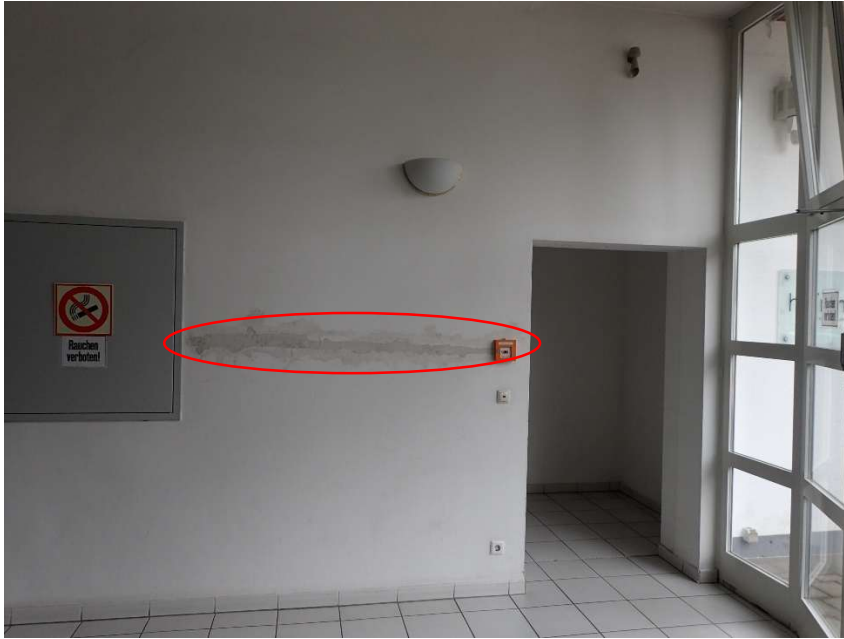
Stiegenhaus 13, Erdgeschoss (Wandschlitz, Zugang Aufzug)
