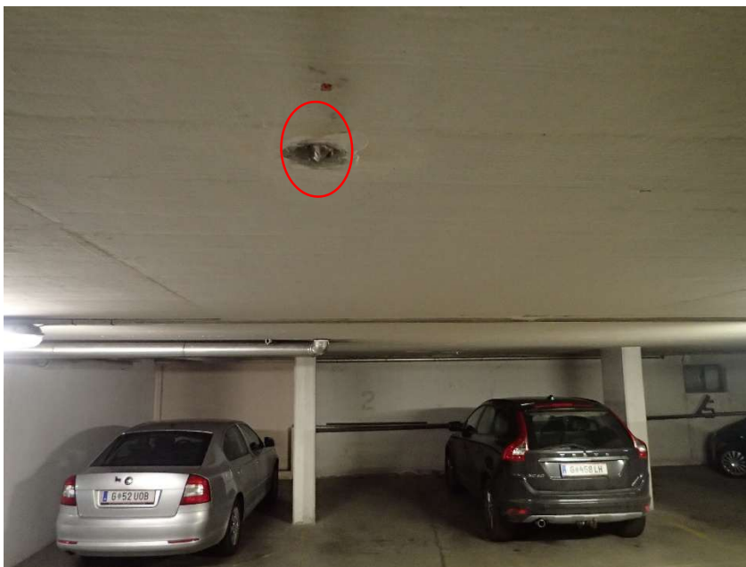
Tiefgarage (Leitung DDB Deckenuntersicht Stellplatz 02 - 31)
