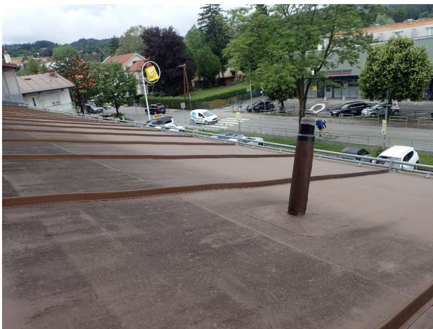
Gebäudeteil 13, Nordfassade (Dacheindeckung mit Einzelanschlagpunkt)
