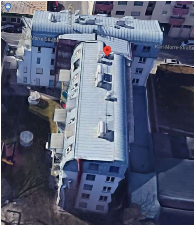
231028 Photos Google BV Karl Morre Straße 47 05.jpg
