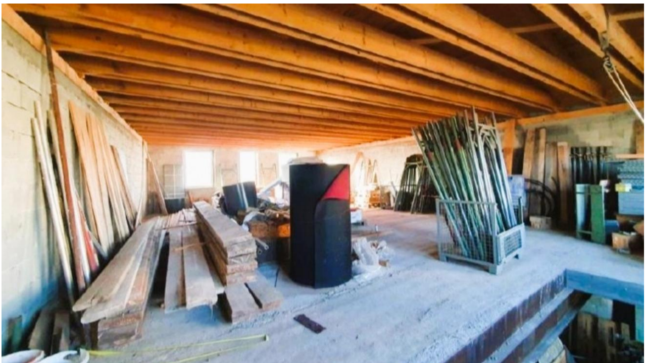
Lagerhalle - Obergeschoss / Zwischendecke
