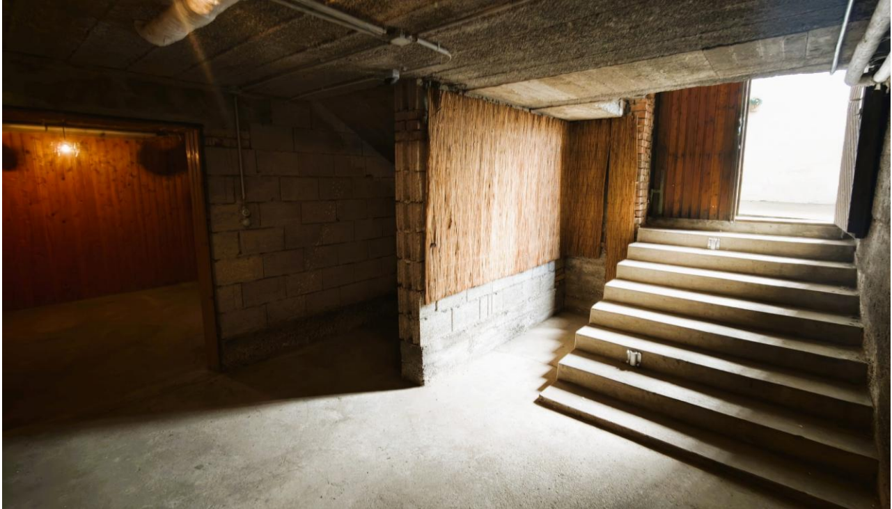
Kellerbereich - Zugang und Nebenfläche
