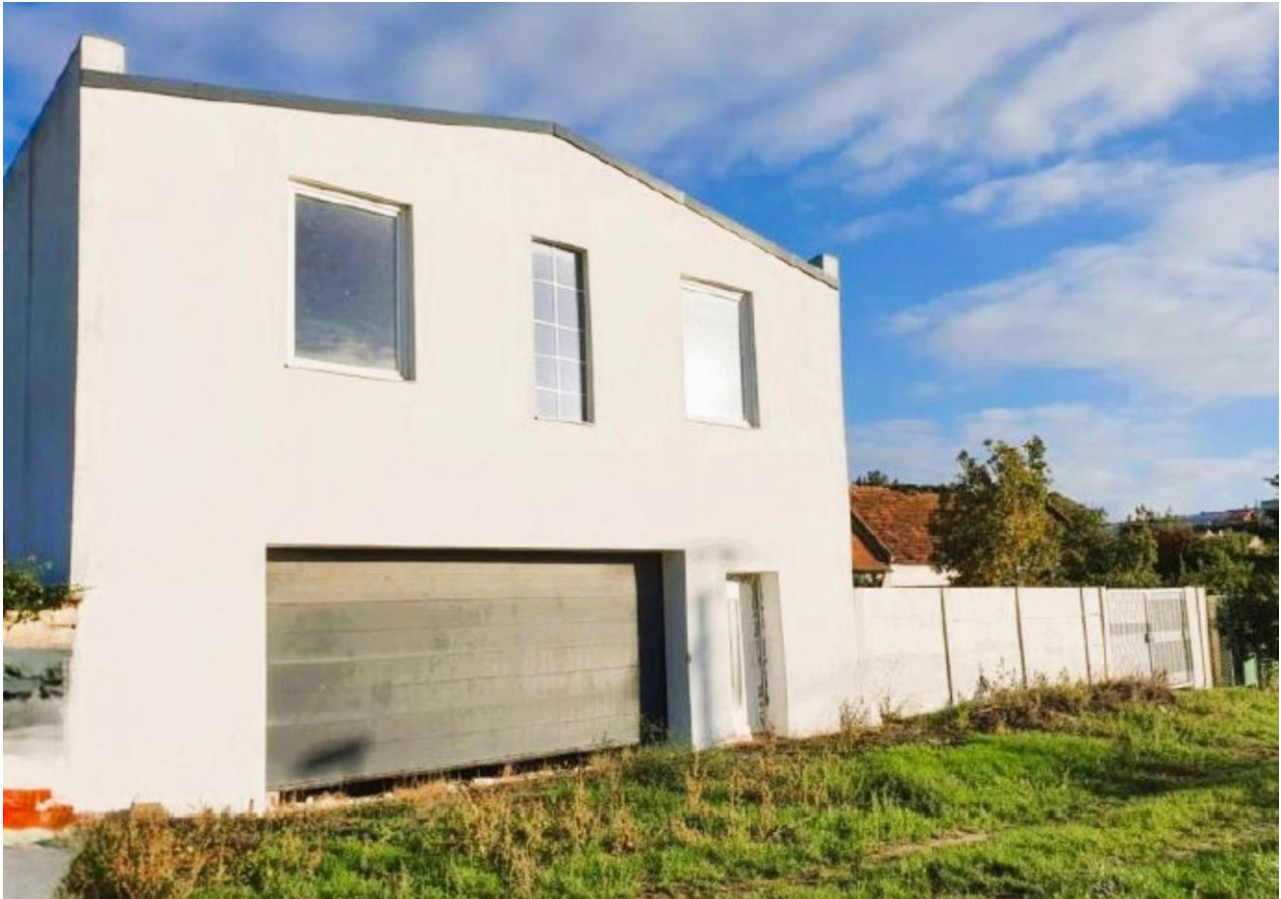
Lagerhalle - Bahnseite / Außenansicht
