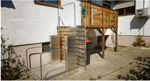
Außenzugang mit vorhandenem Plattformlift
