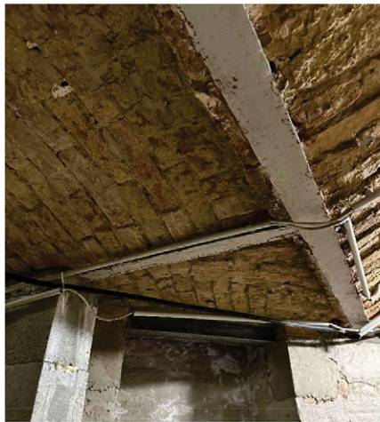
Bild 4: Gewölbedecke + Träger
