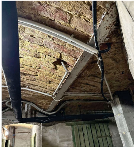
Bild 3: Gewölbedecke + Träger
