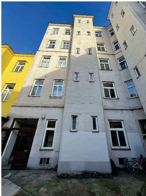
Bild 1: Ansicht Richtung Quellenstraße
