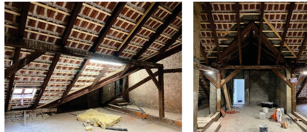
Bild 3+4: Dachstuhl neue Eindeckung
