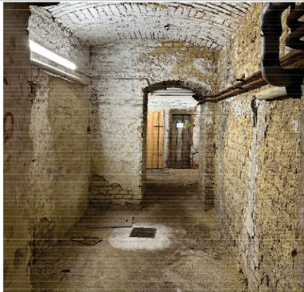
Bild 1: Kellerwände Eingang Keller
