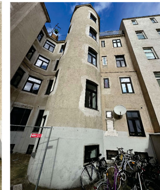
Bild 2: Ansicht Richtung Tellgasse
