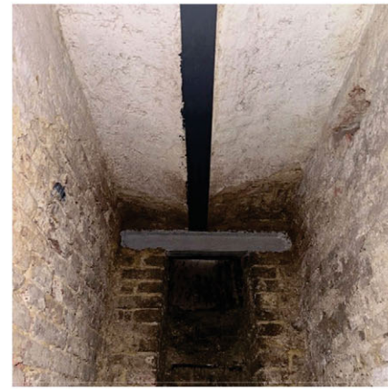
Bild 2: Gewölbedecke + Träger
