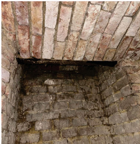
Bild 4: Gewölbedecke + Träger
