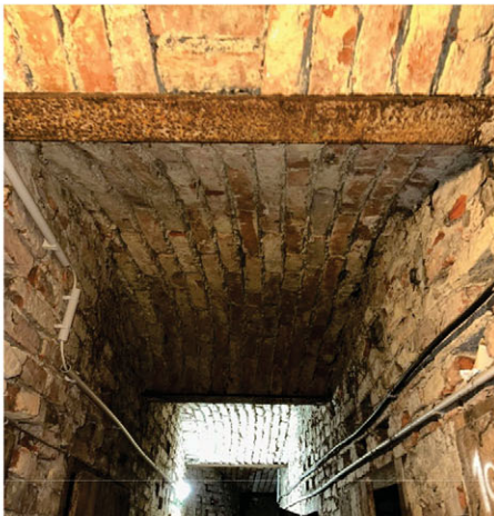
Bild 3: Gewölbedecke + Träger
