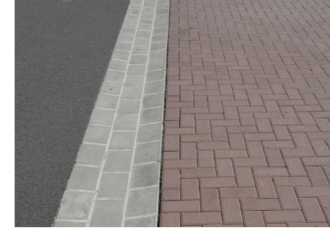
Referenzbild Entwässerungsmulde Material: Betonsteine
